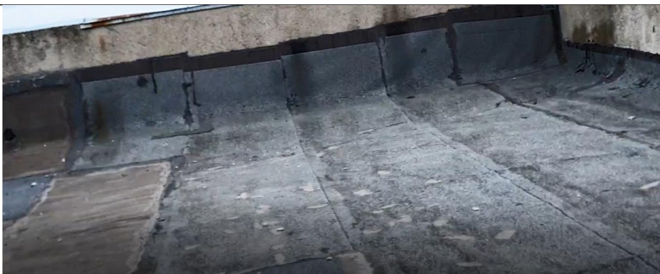
Figura 8: Aspect straturi terasă scara A
