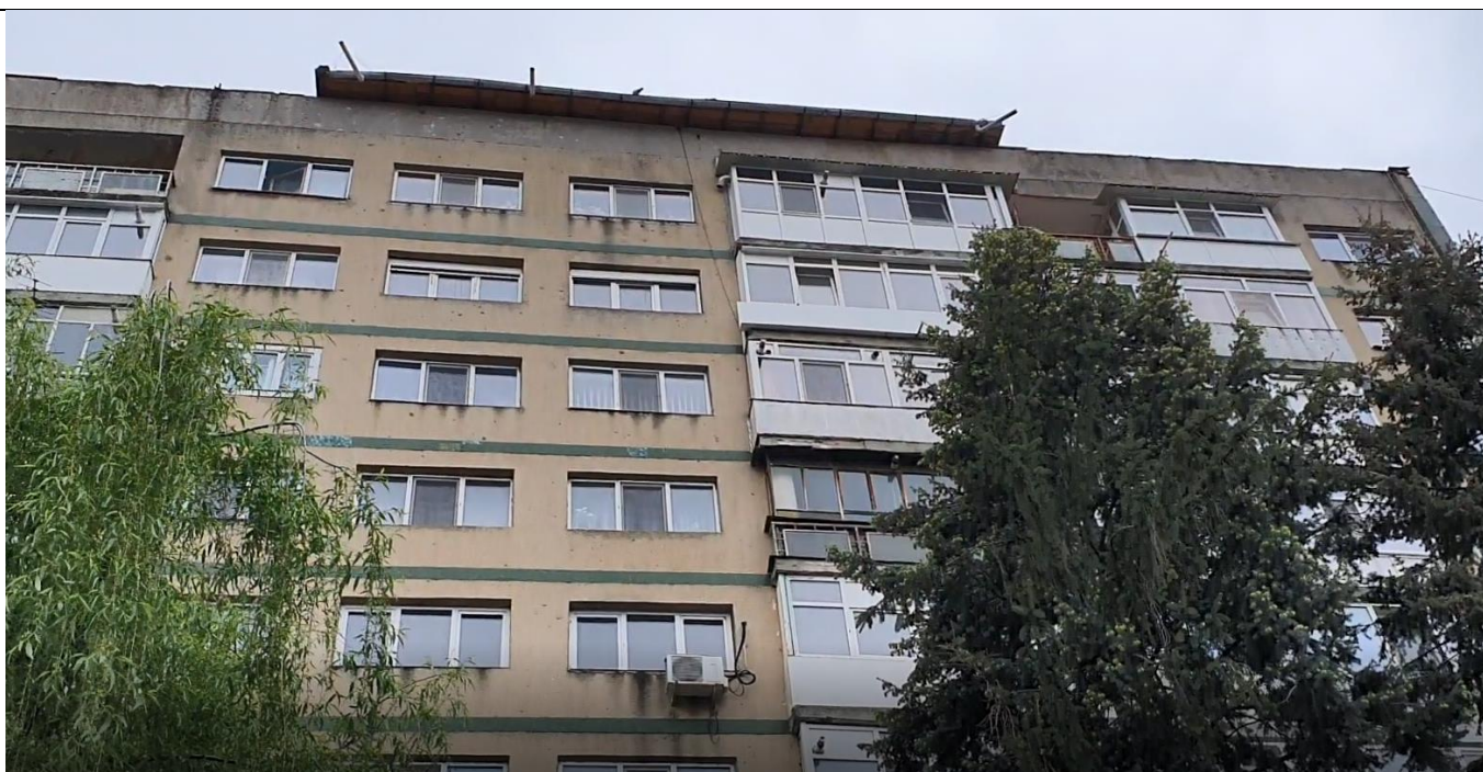
Figura 2: Fațada intrare scara A
